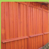
Ściana odeskowana Fully planked wall Wand ganz verschalt
